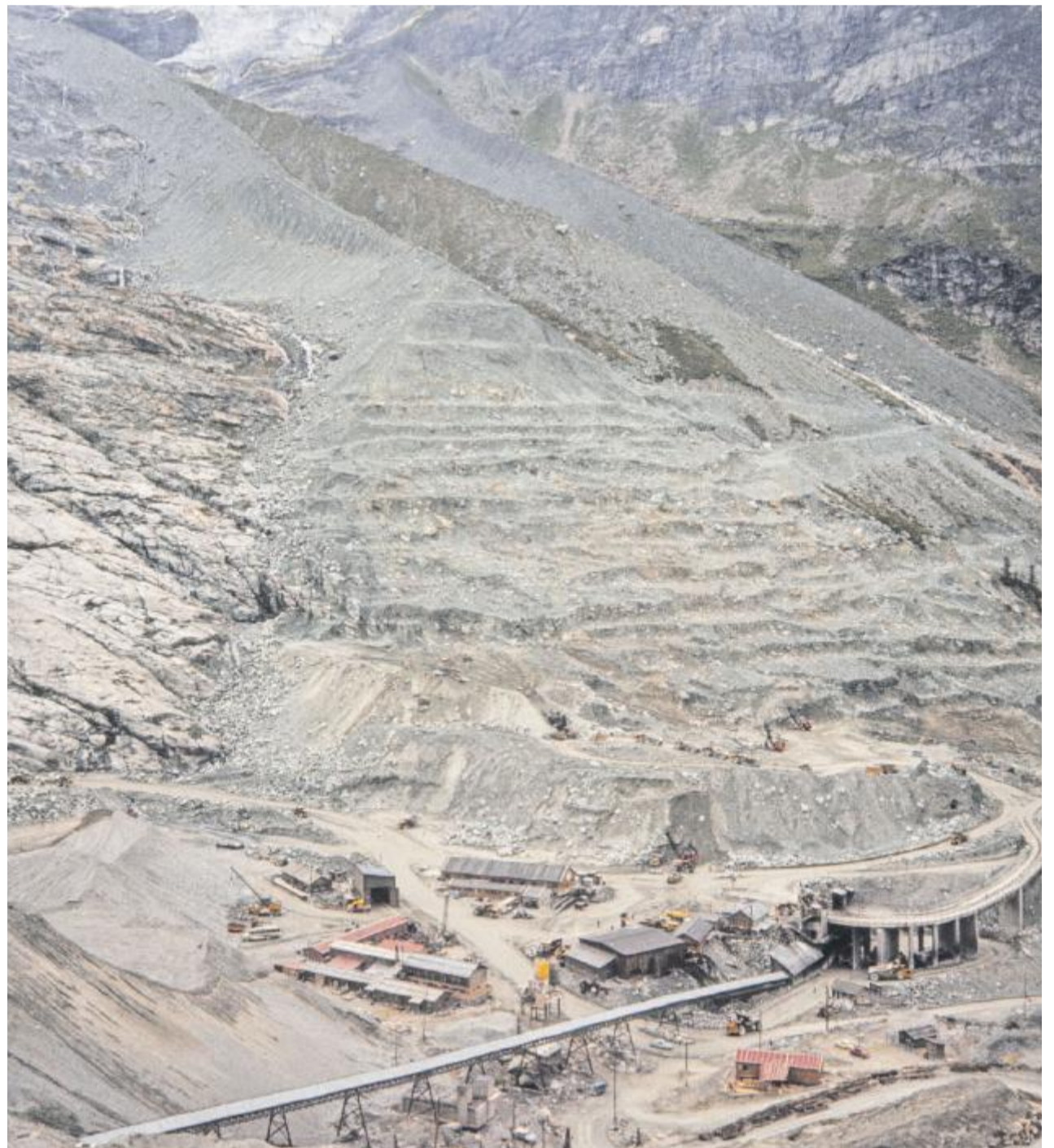
Damoklesschwert. Die Barackenlager beim Staudamm Mattmark befanden sich in der Bauphase direkt in der Falllinie des Allalingletschers. Wäre der Gletscherabbruch während der Zeit des Mittagessens geschehen, hätten wohl 700 Arbeiter den Tod gefunden. Die Aufnahme wurde einige Monate vor der Katastrophe gemacht.
